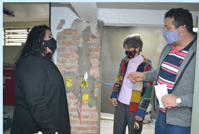
Reboco executado no espaço de atendimento
